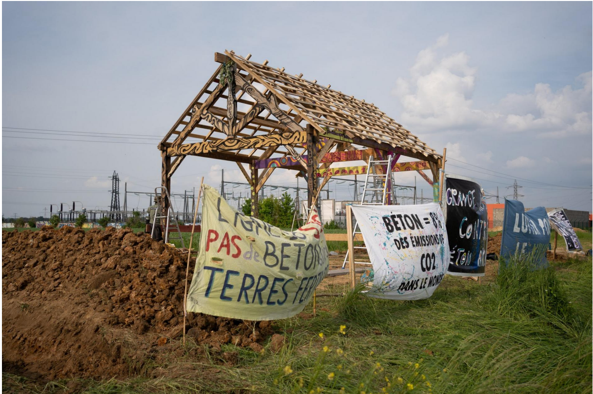
La grange en construction, dimanche 14 mai au soir.
